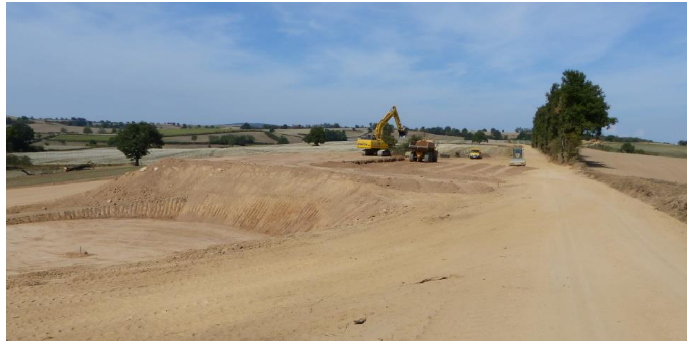
Différentes phases d'un chantier éolien (Source : Corieaulys et Boralex)
